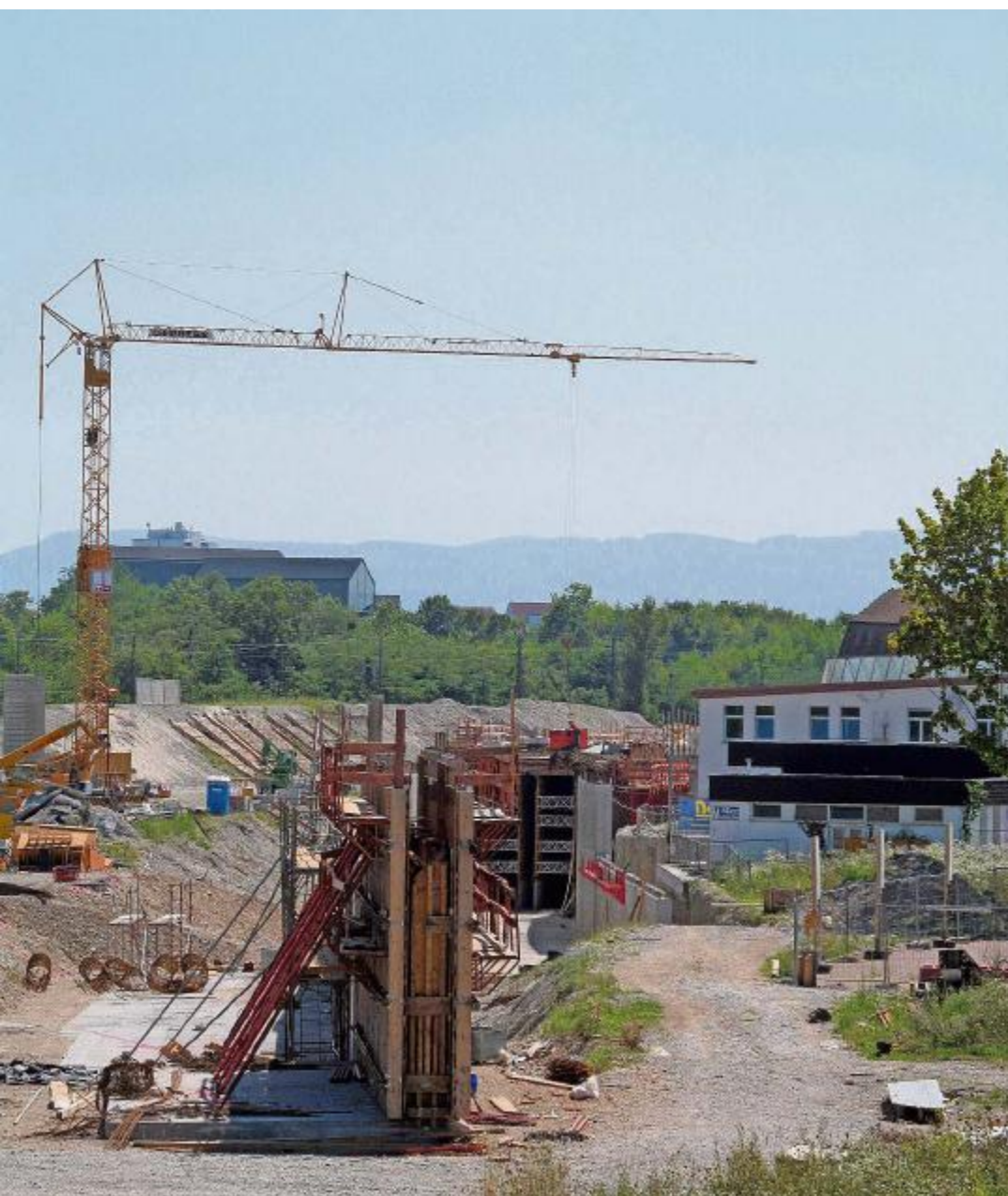
In Weil-Haltingen geht es vorwärts, weiter nördlich hingegen harzt die Grossbaustelle. DB
