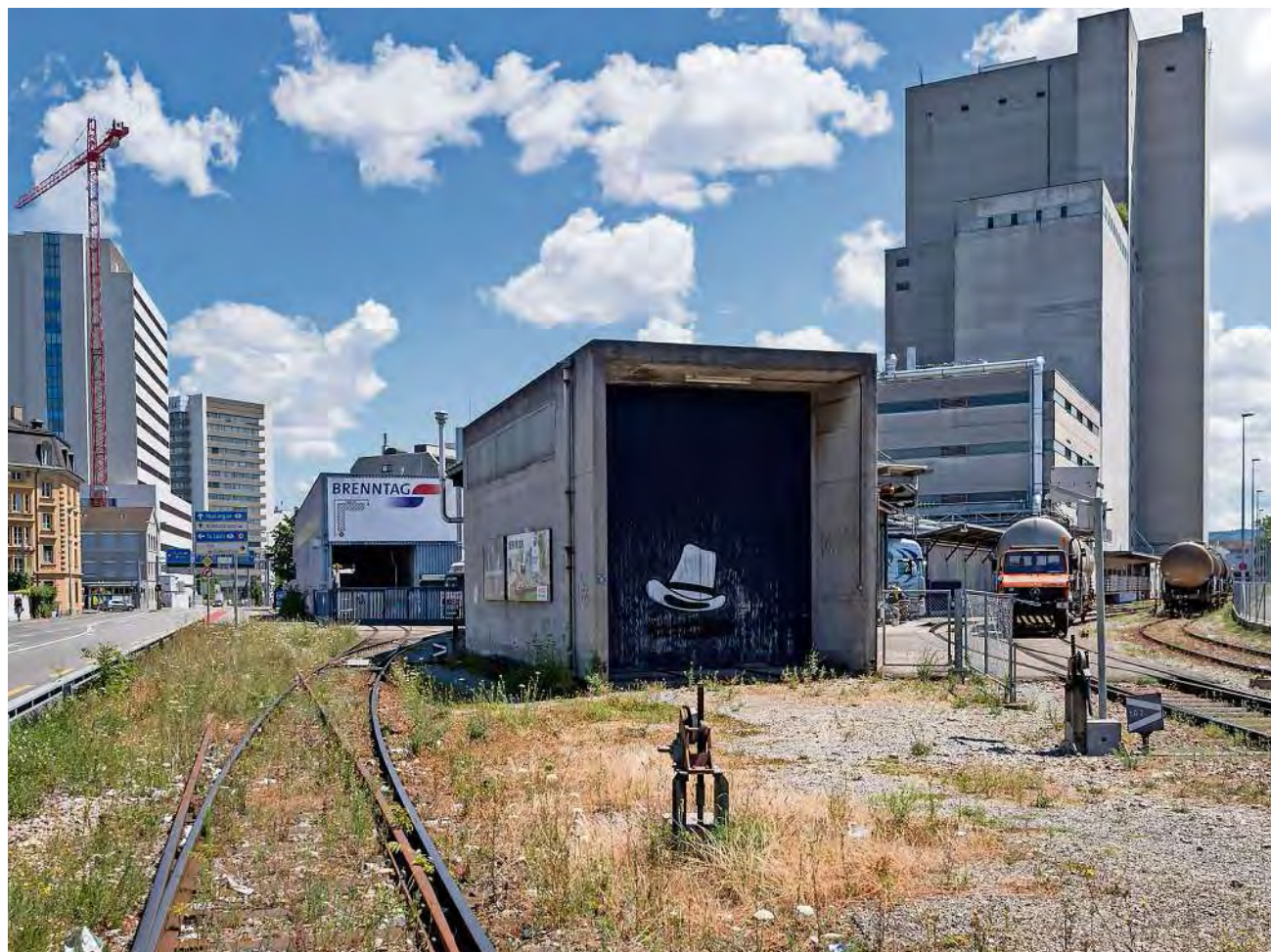
Geleise ins Nichts. Auf dem Lysbüchel-Areal sollen sich dereinst Gewerbetreibende, Mieter und Schüler begegnen. Keystone
